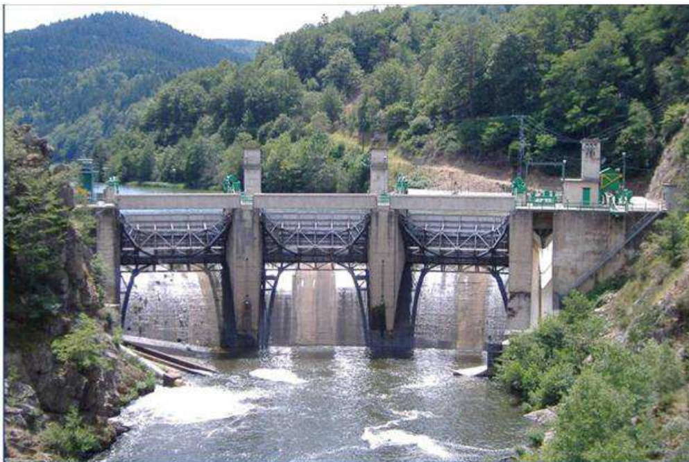
Photo 1 : Vu aval du barrage de Poutès
